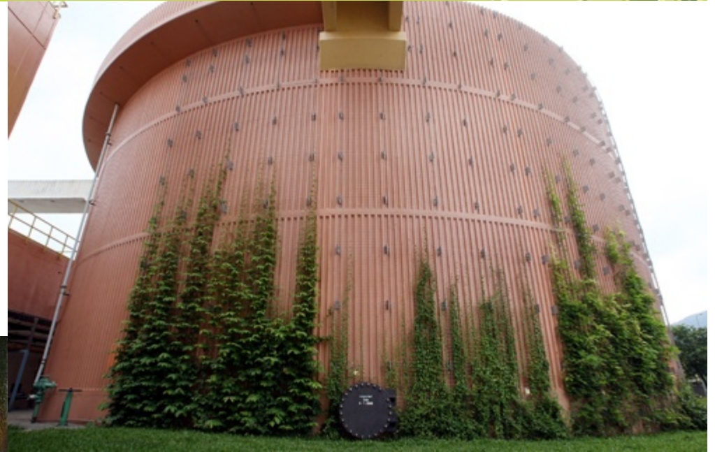
垂直綠化——沙田污水處理廠
